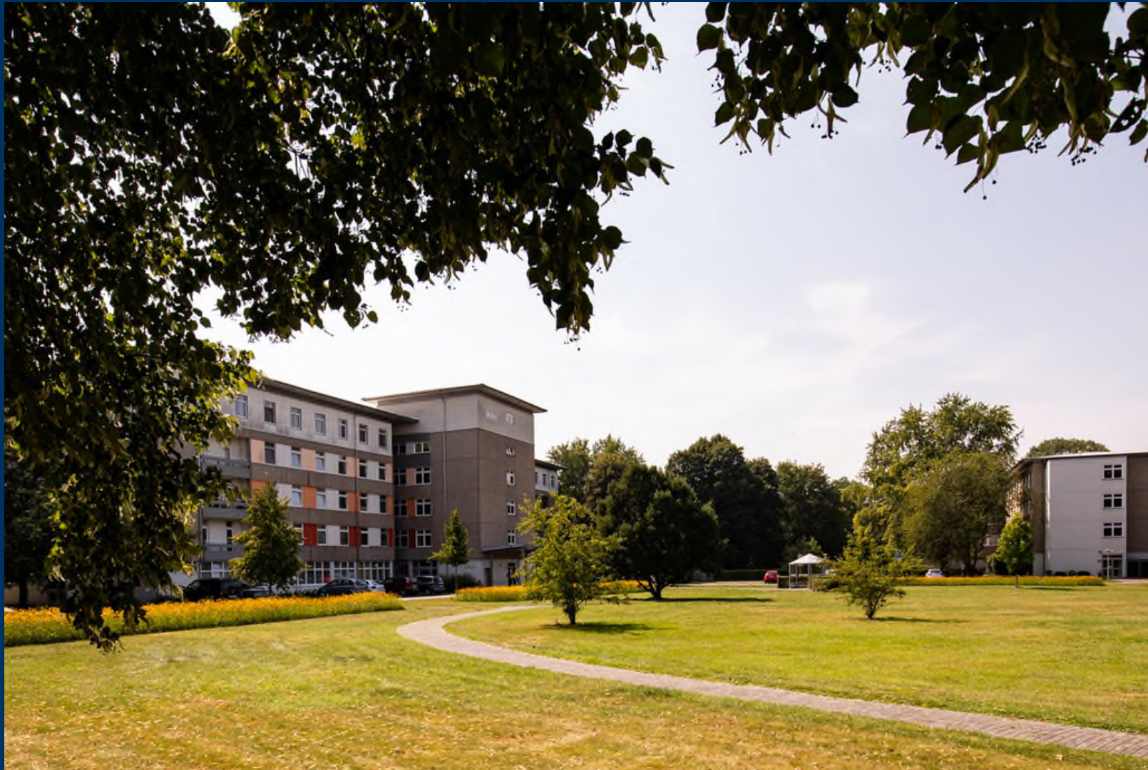
Klinikgebäude B15 (links) und B16 (rechts) in Lippstadt-Benninghausen
