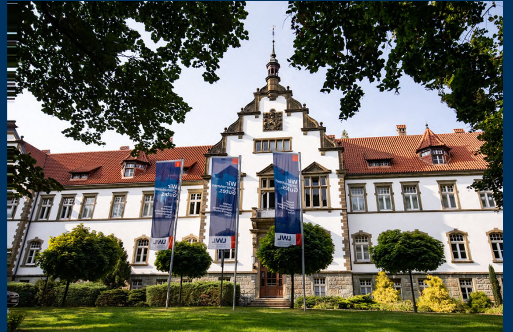
Verwaltungsgebäude W01 in Warstein
